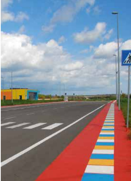
I lavori di riqualificazione urbana della zona 167 di via Acquarica
