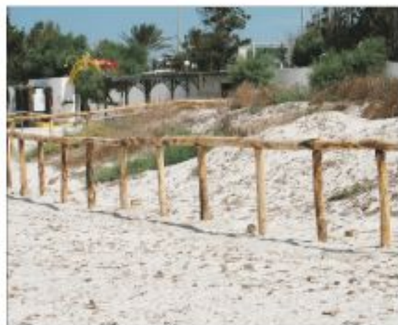
Le immagini ritraggono le passerelle e le stazioni in legno predisposte lungo la fascia costiera di Ugento per un tratto di circa 3 km. Installate per proteggere dal passaggio del uomo gli antichi dune e retrodune, fondamentali per il loro valore conservazionistico e per il ruolo di difesa dall'erosione costiera, permetteranno l'accesso al mare in maniera controllata e rispettosa dell'ambiente.
